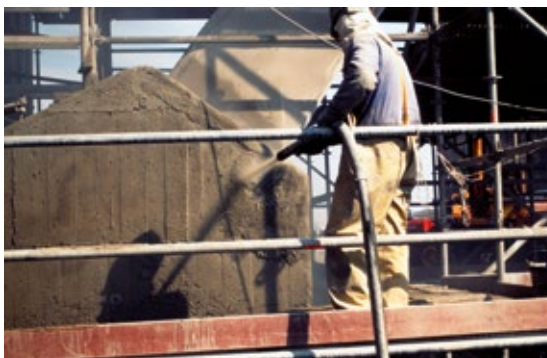
lokální náhrada betonu
